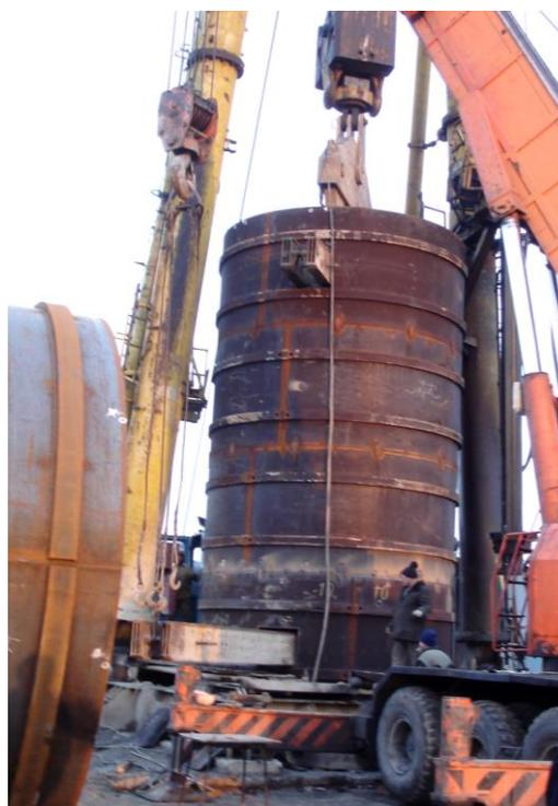
Рисунок 3. Монтаж колонны труб на устье скважины
